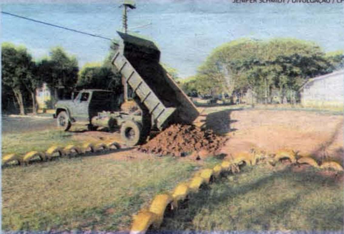
Obstáculos começaram a ser construídos
