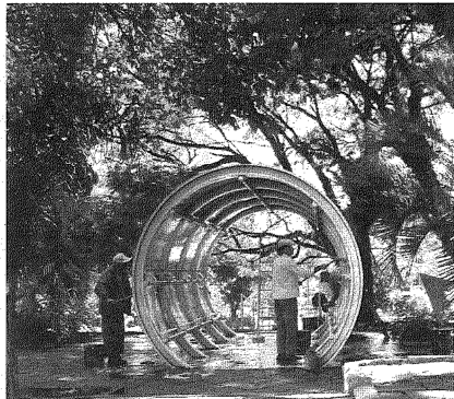
Serviços de manutenção estão sendo realizados
