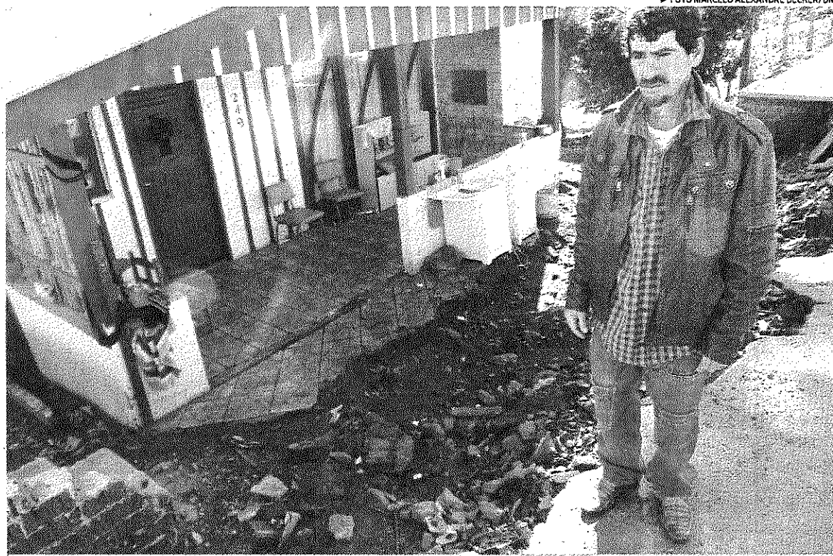
Problema segue desde dezembro. Secretário afirma que em até 15 dias trabalhos de reparo devem ter início
